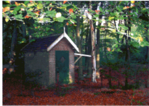
Het originele lijkenhuisje uit ca. 1879 is eenvoudig en sober vormgegeven en behoorde bij de voormalige begraafplaats van Arca Pacis.
